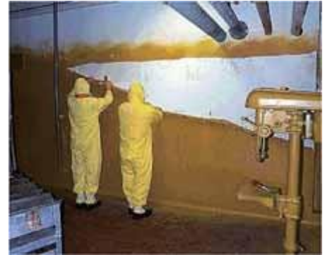
剥離性塗料による封じ込め及び除染状況
