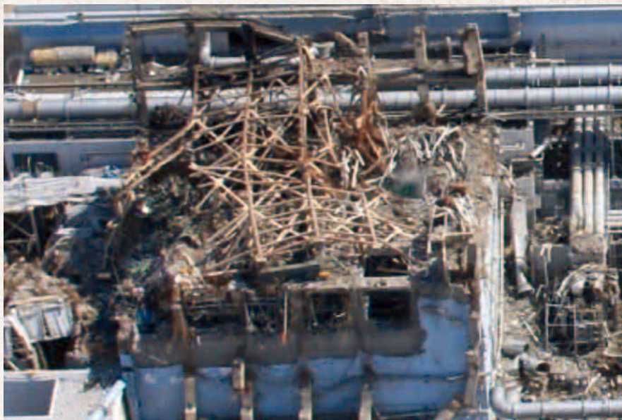
1F-3号機 原子炉建屋5階 事故直後の状況
