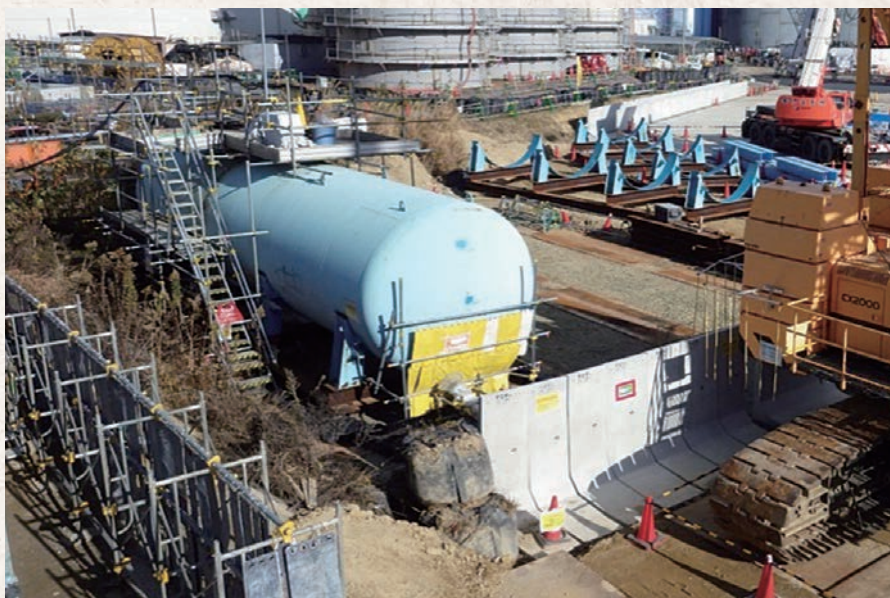
汚染水タンク解体時のL型コンクリート擁壁及び鉛板遮へい衝突による遮へい状況写真 資料提供:大成建設(株)
